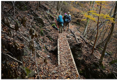
上は作業前の様子。ポイント1の中間にある老朽化した橋の場所。
