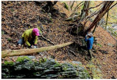
倒木をノコギリで切断し、登山道の足場を利用する。また、太い木を選び支点を作る。
