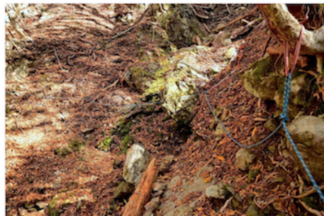
ポイント1の各地形の場所の整備完了後の様子。 細いトラバースの道に手すりできました。
