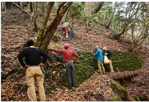
ポイント2の様子。古い補助ロープを全て取り替えた。
