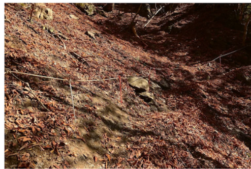
作業後の様子。鉄の杭を多数使用してロープを張った。
